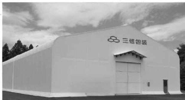
8月25日に引き渡しを受けた資材倉庫
