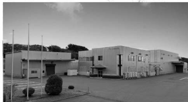
工場建屋とフィルム棟
