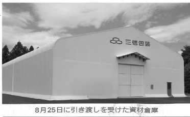
8月25日に引き渡しを受けた資材倉庫
